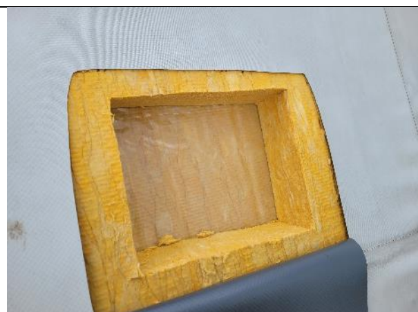
Här ligger plastfolien mellan isoleringen. 5 + 10 cm isolering
