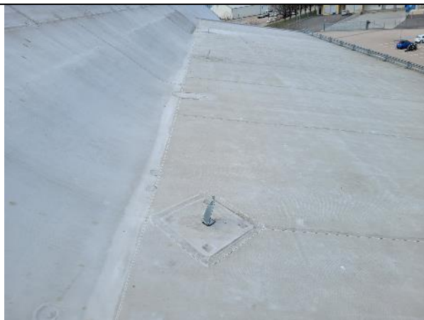
Säkerhetsfästen är något böjda här men inte alls som mot söder
