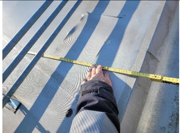
Plywood under ca 75 cm upp från takfot
