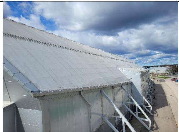
Vy över taket mot norr
