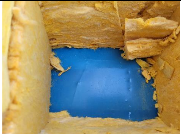
Inga uppenbara skador i konstruktionen
