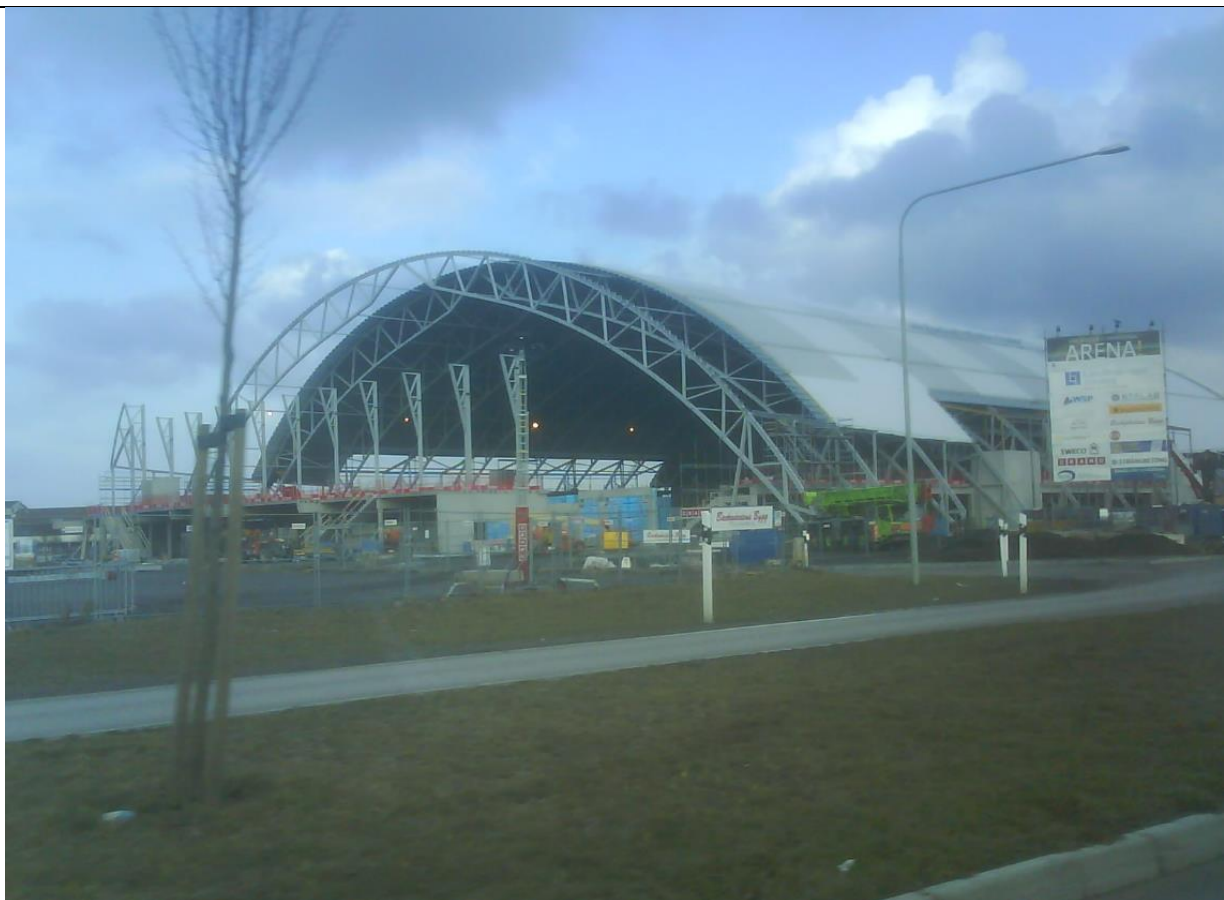
28 mars 2009 under byggnationen, bild från Wikipedia
