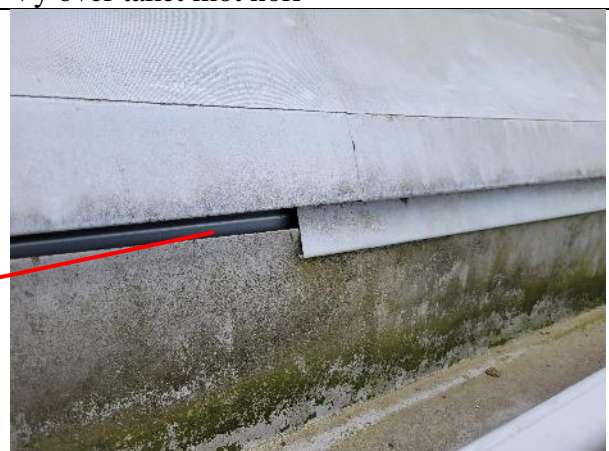
Här är fotplåten lite kort, man har dock till viss del förlängt den med en bit plåt
