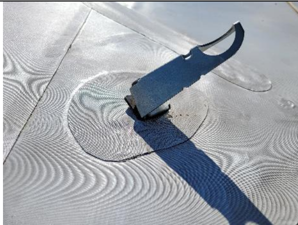
Säkerhetsinfästning böjd
