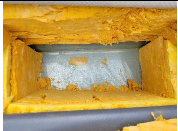
Inga tydliga missfärgningar på plastfolien här
