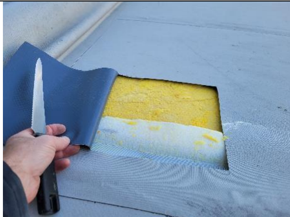
Provhål nr 9 tas i närheten av gavelväggen
