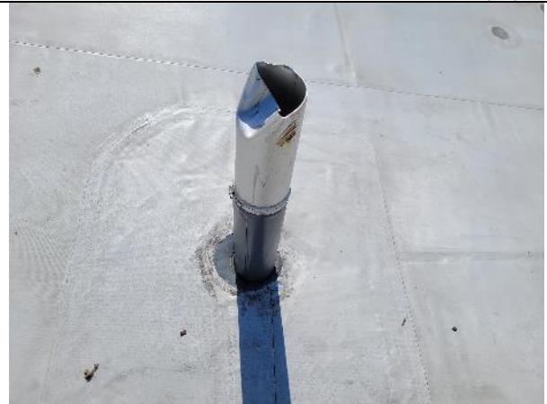
Avloppsluftare skadad
