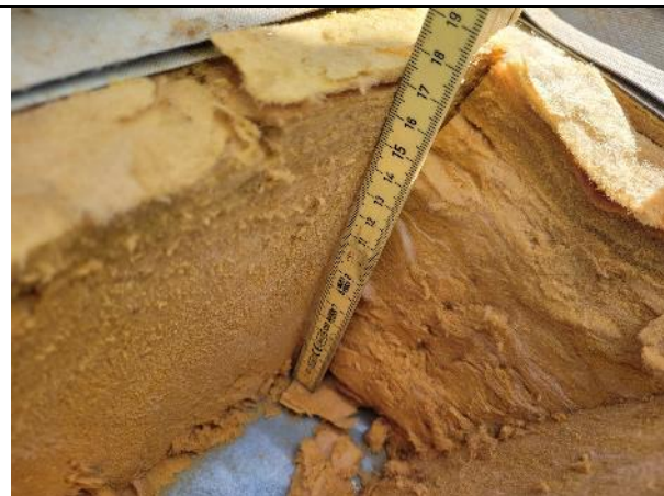
Totalt 17 cm isolering här
