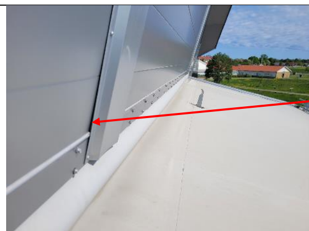
Otättheter förekommer i sandwichskarvar
