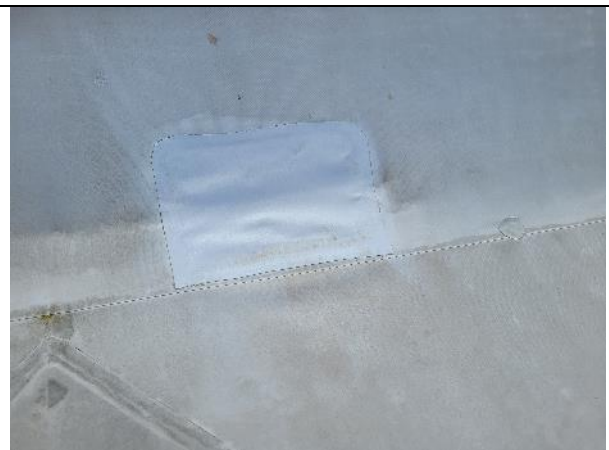
Taket lagas efter inspektionen
