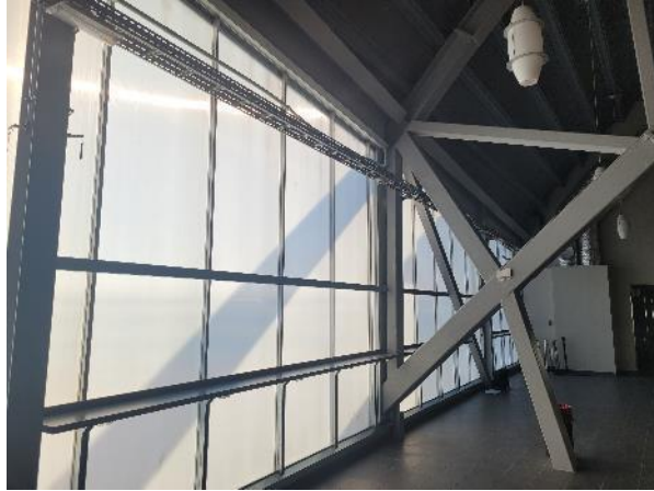
Vy över yttervägg mot norr, plan 2
