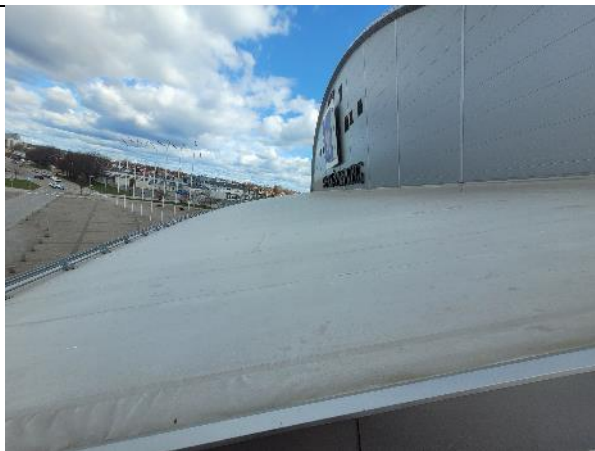
Vy över tak mot väster
