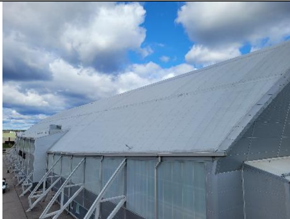
Vy över del mot söder
